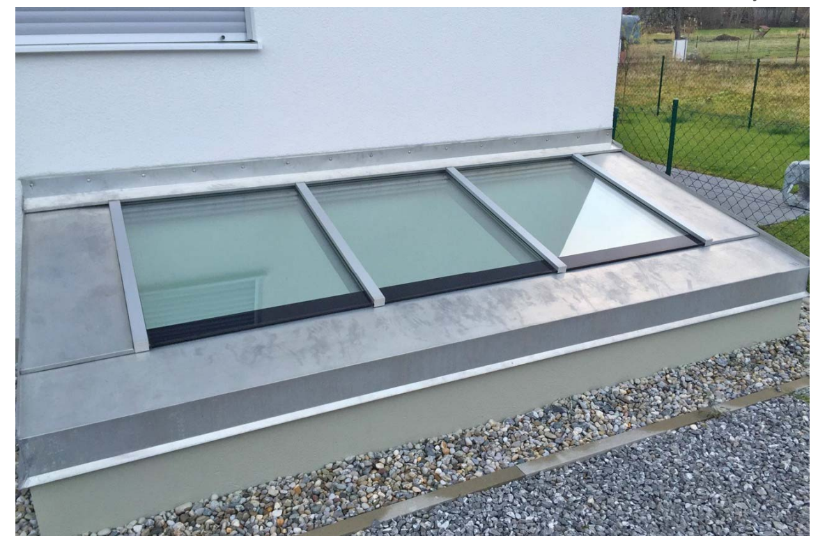
Glasdach über Hobbyraum
