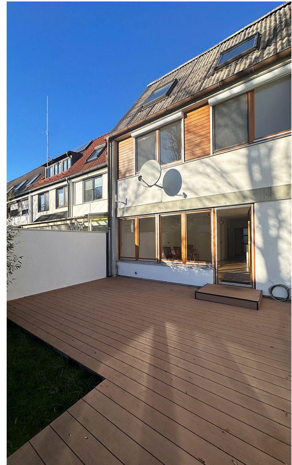
Südansicht mit großer Terrasse
